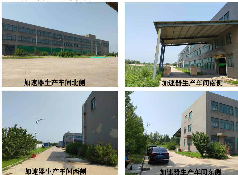
图 1-2 加速器生产车间周边现场照片
