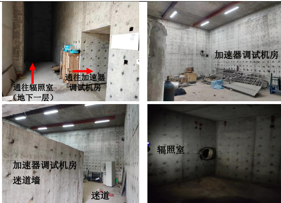
图 1-3 加速器调试机房和辐照室现场图
